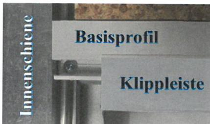
Dann befestigen Sie die Klippleiste des Laibungsputzabschlussprofils am Basisprofil. Falls noch vorhanden, entfernen Sie bitte die graue Schutzfolie der Klippleiste.
