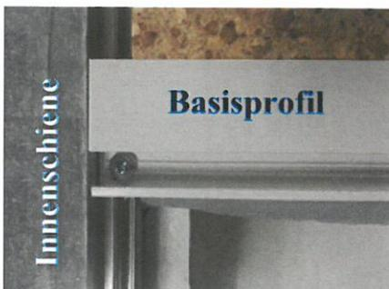
Das Basisprofil wird an der Innenschiene des Rolladenkastens, mit Hilfe einer Schraube, befestigt.
